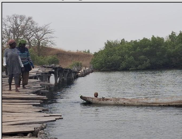
L'un des ponts de Thionck-Essyl, qui permet de relier le village aux rizières.
